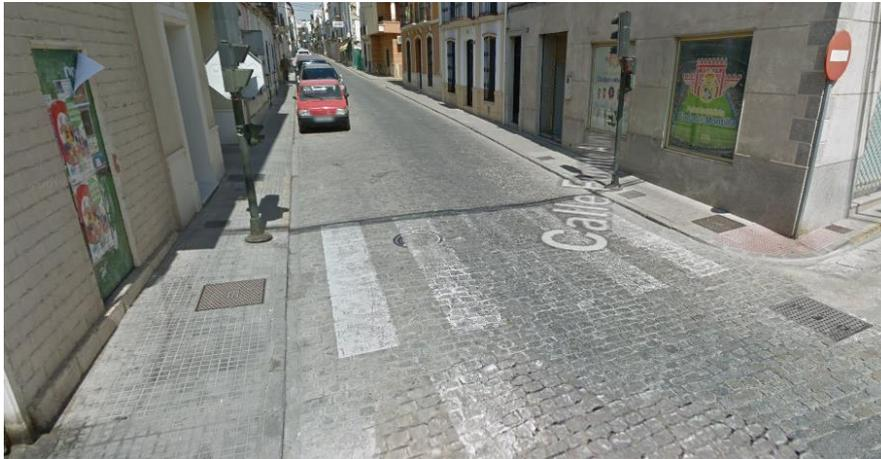
**Figura 26: Ancho insuficiente y sin rebaje para PMR en la Calle Fuente Álamo**
